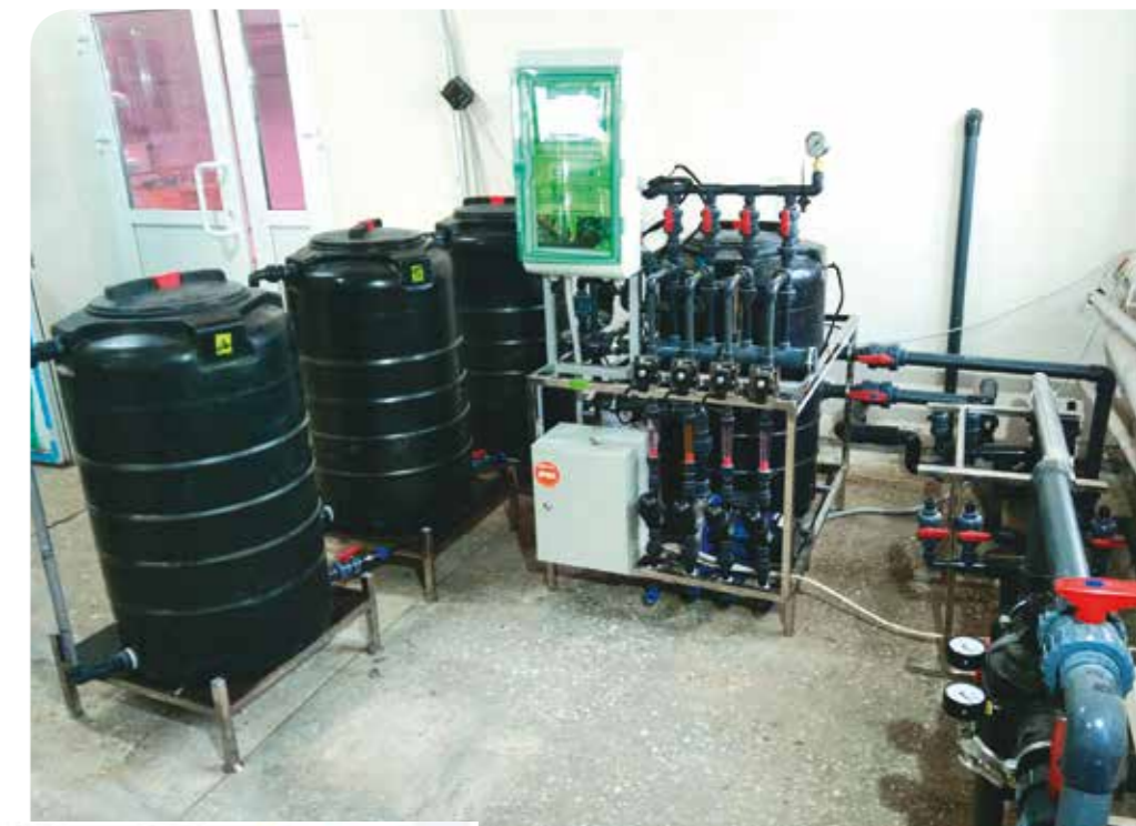
Оборудование для полива
