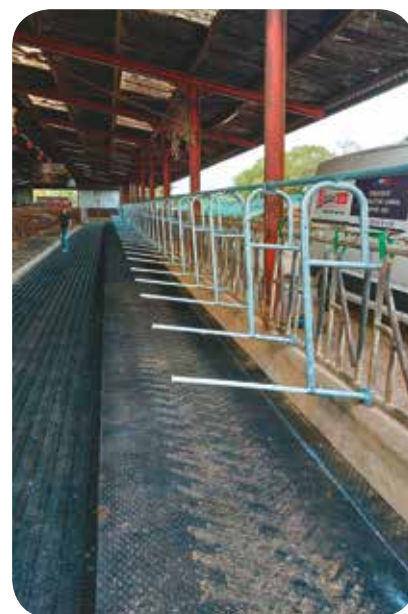
Разделители DiviZen стали обязательным оборудованием в новых стандартах строительства помещений для молочных коров в Швейцарии и получают широкое распространение на фермах в Европе
