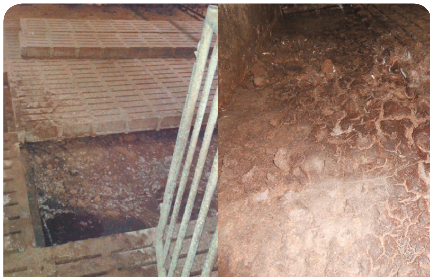
Фото 2. Часто источником повышенного уровня вредных газов становятся переполненные, несвоевременно опустошаемые навозные ванны. Никакое прогрессивное, дорогостоящее оборудование в этой ситуации не справится!
