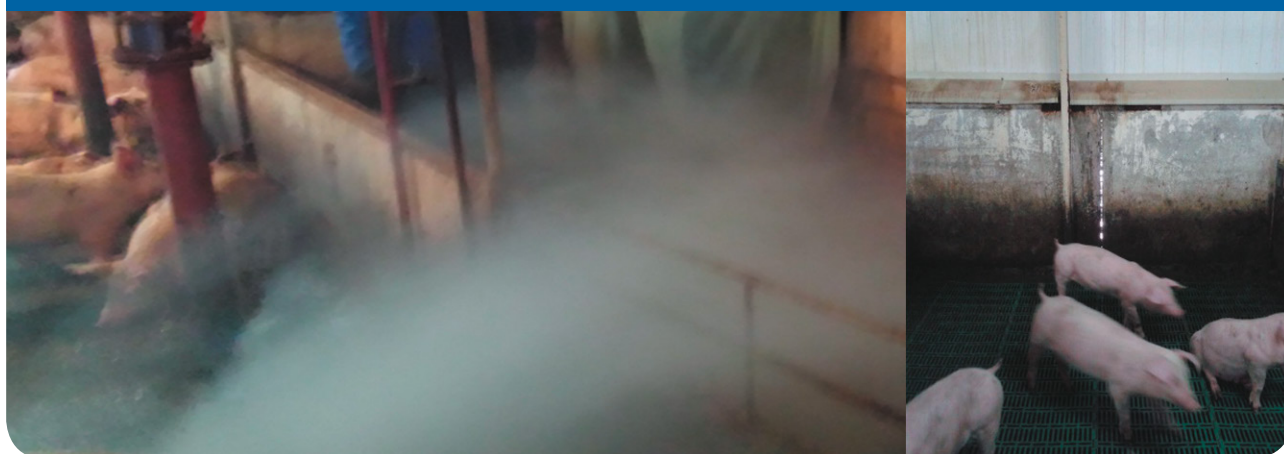
Фото 3. Слева – холодный воздух бесконтрольно поступает из щелей тамбура прямо в станок к животным. Справа – щель в смежной с улицей стене. При высоком уровне вентиляции в зимний период поросята будут располагаться как можно дальше от такого места
