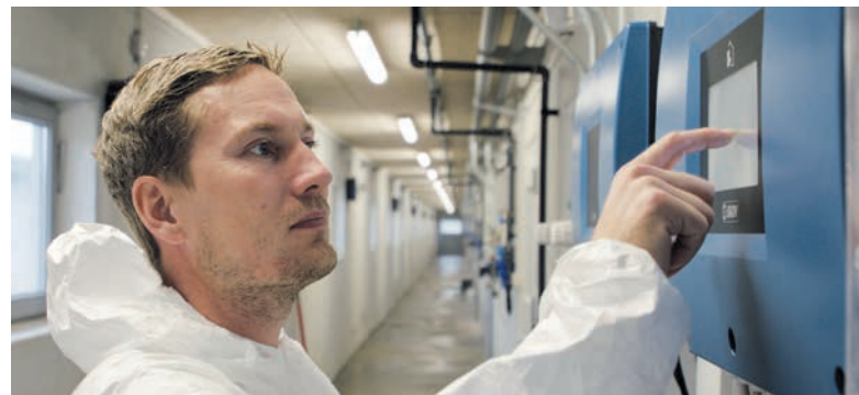
Новый контроллер SKOV позволяет управлять не только микроклиматом, но и процессами производства, включая раздачу и аккуратное взвешивание корма в помещении со свиньями
