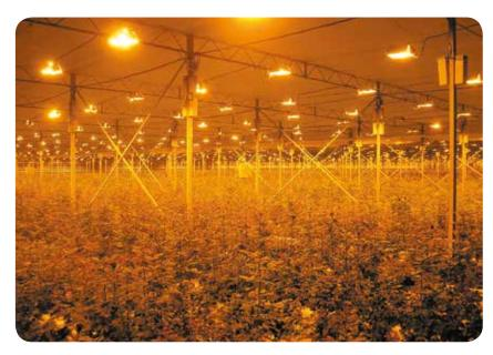
Чтобы предотвратить частые переключения и быстрый износ ламп, в PRIVA предусмотрены зоны нечувствительности – значение выше и ниже заданного, которое отделяет его от порога включения/выключения, обеспечивая устойчивое переключение, и суммы отклонений – суммы разностей между измеренным значением и заданным. Переключение происходит при достижении заданной суммы отклонений. Возможно также пошаговое отключение ламп для плавного подключения и отключения нагрузки.
