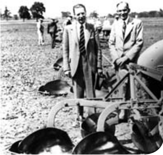
Одно из важнейших изобретений в истории тракторостроения – трехточечная система навески Г. Фергюсона для прицепного оборудования
