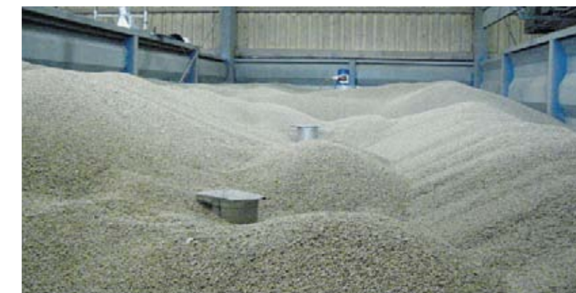
Фото 1. Вентиляционные колонки: а – загрузка хранилища; б – вентиляция с одним вентилятором нескольких колонок
