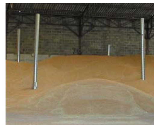
Фото 1. Вентиляционные колонки: а – загрузка хранилища; б – вентиляция с одним вентилятором нескольких колонок
