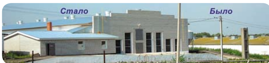
Фото 2. Идет реконструкция птицефабрика «Комсомольская» в Челябинской области
