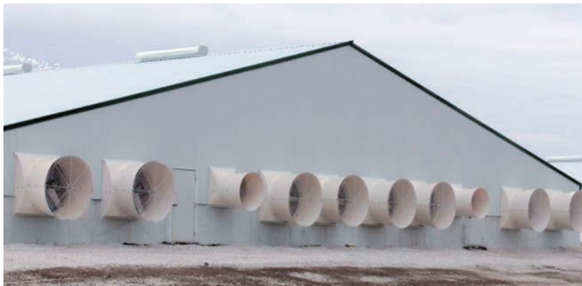
Рисунок 2. Вентиляторы разной мощности, предназначенные обеспечить минимальный, средний и максимальный уровень вентиляции
