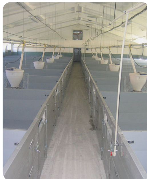
Помещение для подсосных свиноматок. Система вентиляции с применением приточных крышных шахт.
