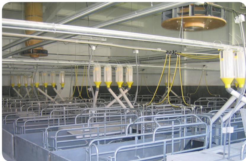
Помещение для подсосных свиноматок. Система вентиляции с применением приточных крышных шахт.
