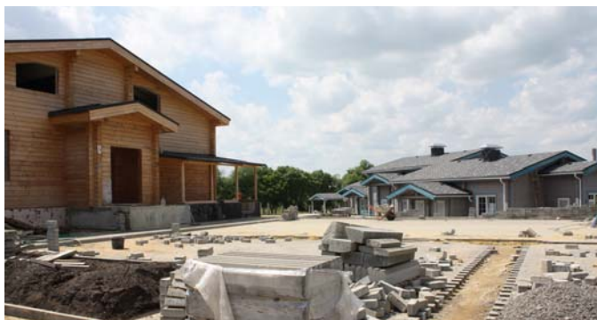
Ведется строительство гостиницы и административного здания компании
