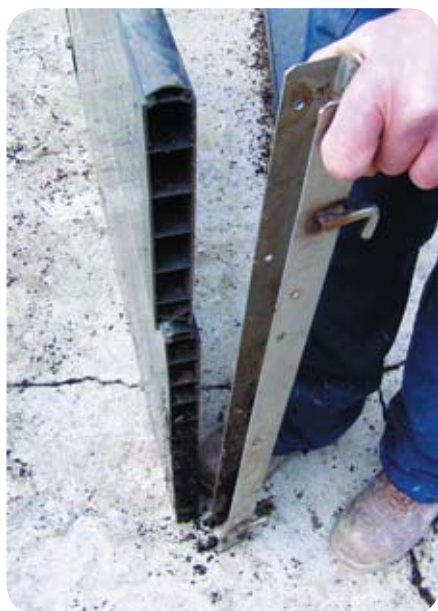
Пустотелые панели через 1,5 года эксплуатации
