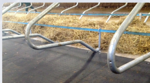
РЕЗИНОВЫЕ ПОКРЫТИЯ ALTEA С УКЛОНОМ 4% на 40 см
